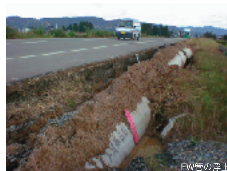
FW管の浮上
