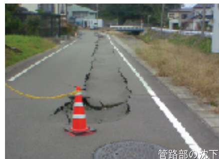
管路部の沈下
