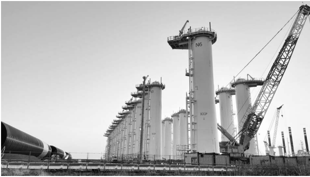
写真－1 基礎部分は港で組立てる
