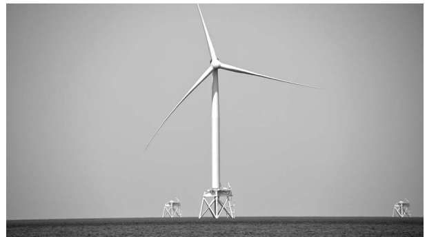
写真－3 完成した風力発電用の風車
