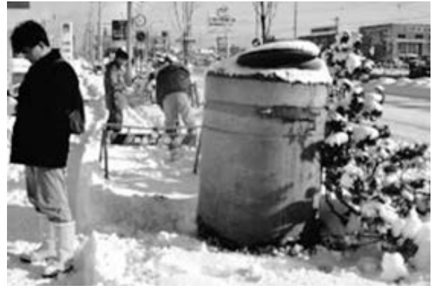
写真－2 1993年釧路沖地震における液状化によるマンホールの浮上（釧路町）
