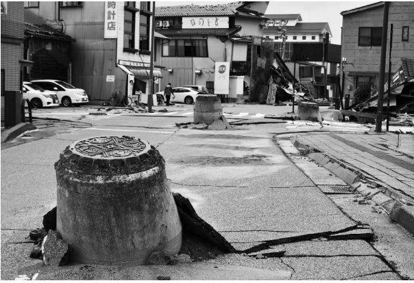
写真－5 2024年能登半島地震におけるマンホールの浮上（輪島市）
