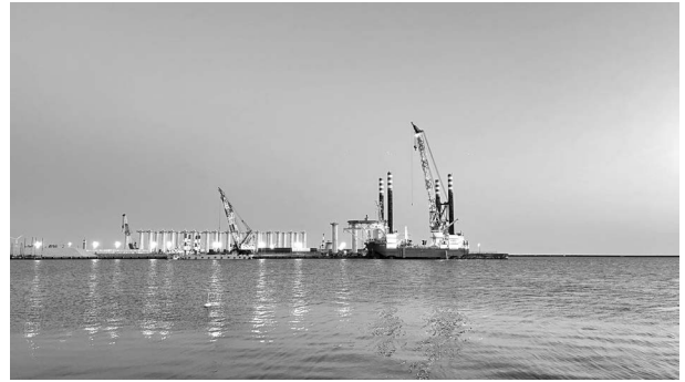
写真－2 洋上に基礎部分を設置
