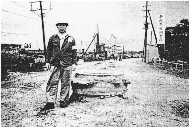
写真－1 1964年新潟地震における液状化によるマンホールの浮上（新潟市）
