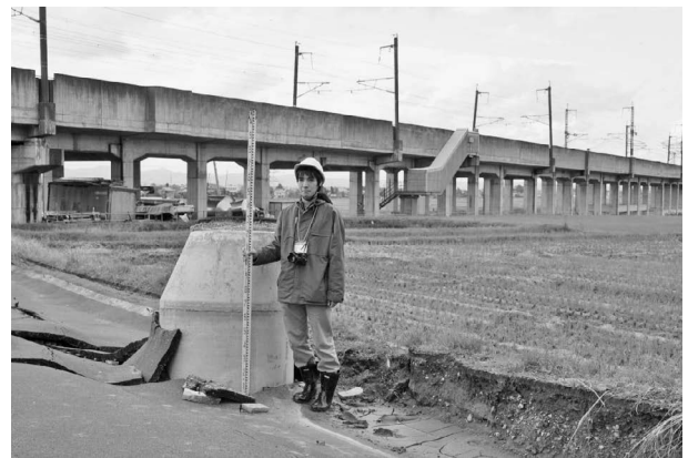
写真－4 2004年新潟県中越地震におけるマンホールの浮上（背後には上越新幹線）
