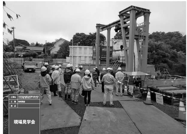
写真-11 現場見学会実施状況
