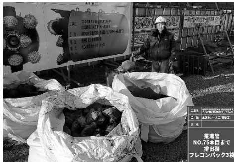
写真-9 破碎排土された巨石群
