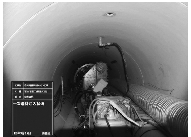
写真-4 滑材注入
