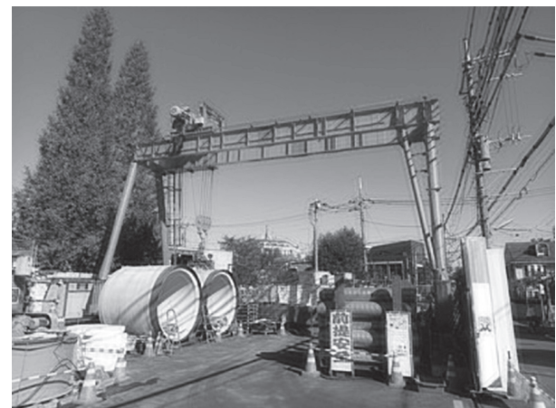
写真－15 施工ヤードの橋形クレーン
