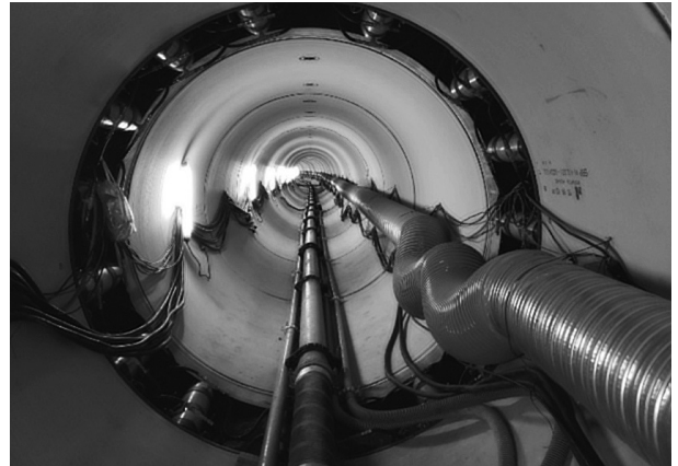
写真-2 中押設備
