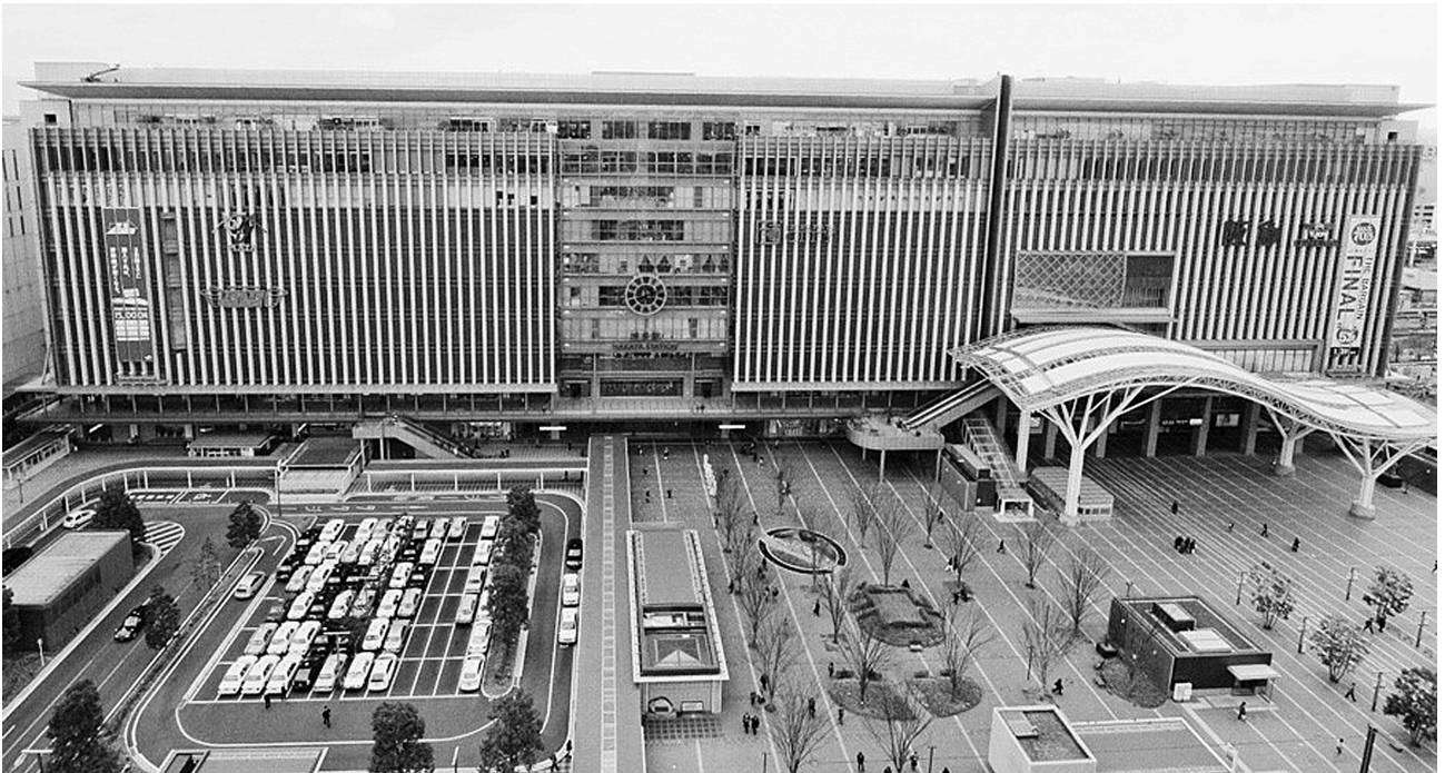
写真-1 福岡の交通の要衝、博多駅
