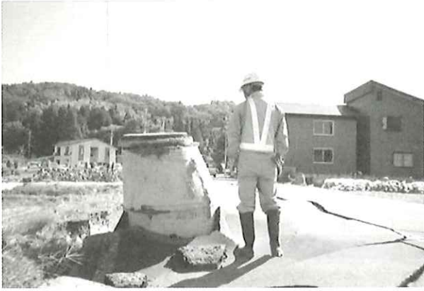
写真-1 長岡市の被災状況 (1号マンホール隆起1.3m)
