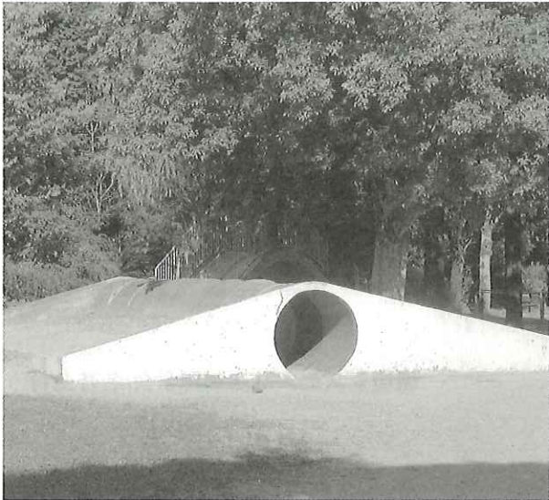
写真-5 ヒューム管の遊具
