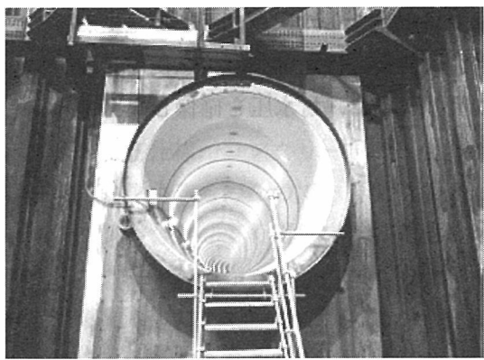
写真－4 発進坑口
