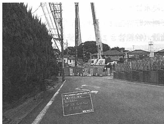
写真－1 発進立坑施工状況
