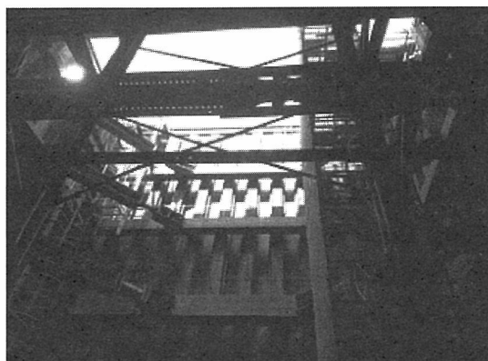
写真－2 発進立坑
