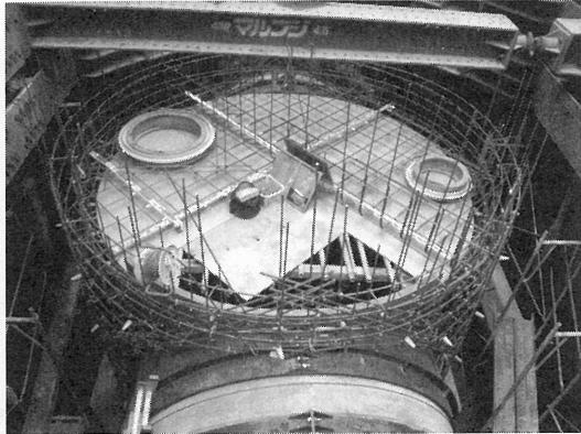
（一子式）の施工法による工事は、内盤底より地盤表面までの高さが約15mと高い。また、土質は主に粘土層であるため、施工中の地盤変動が大きくなる可能性がある。そこで、施工法として滑材注入システムを使用して推進力の低減を図ったことにより、中押し装置は不要となった（写真-10, 11）。
