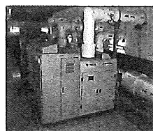
(単段ブロウ) 他自治体の施工例
