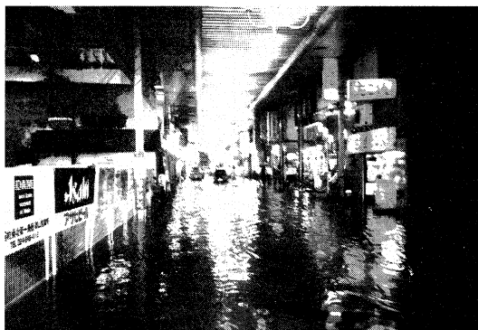
写真-1 浸水状況 (駅前アーケード内)
