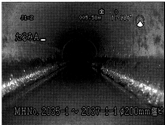
写真-2 ヒューム管の滞水状況
