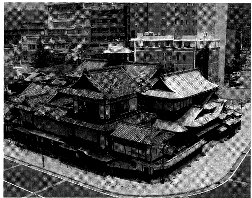
写真-3 冠山から見た道後温泉
