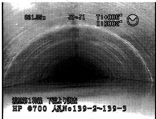
写真-2 ヒューム管の滞水状況
