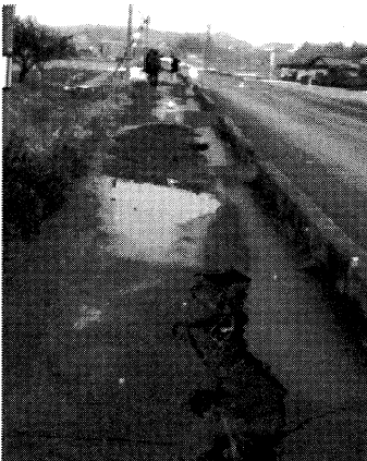
写真-9 標準施工(未対策)
